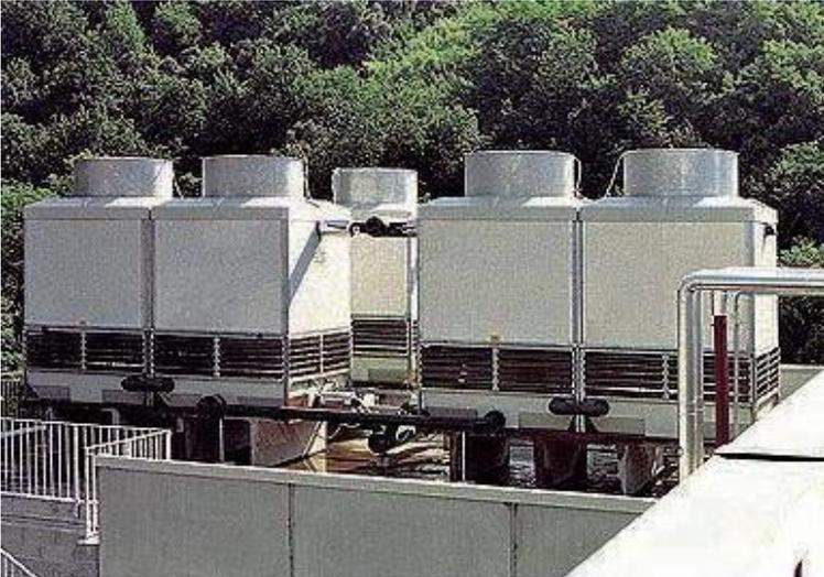
Le torri trovano impiego negli impianti frigoriferi e di condizionamento dell'aria, nei processi industriali, nelle centrali termoelettriche.
